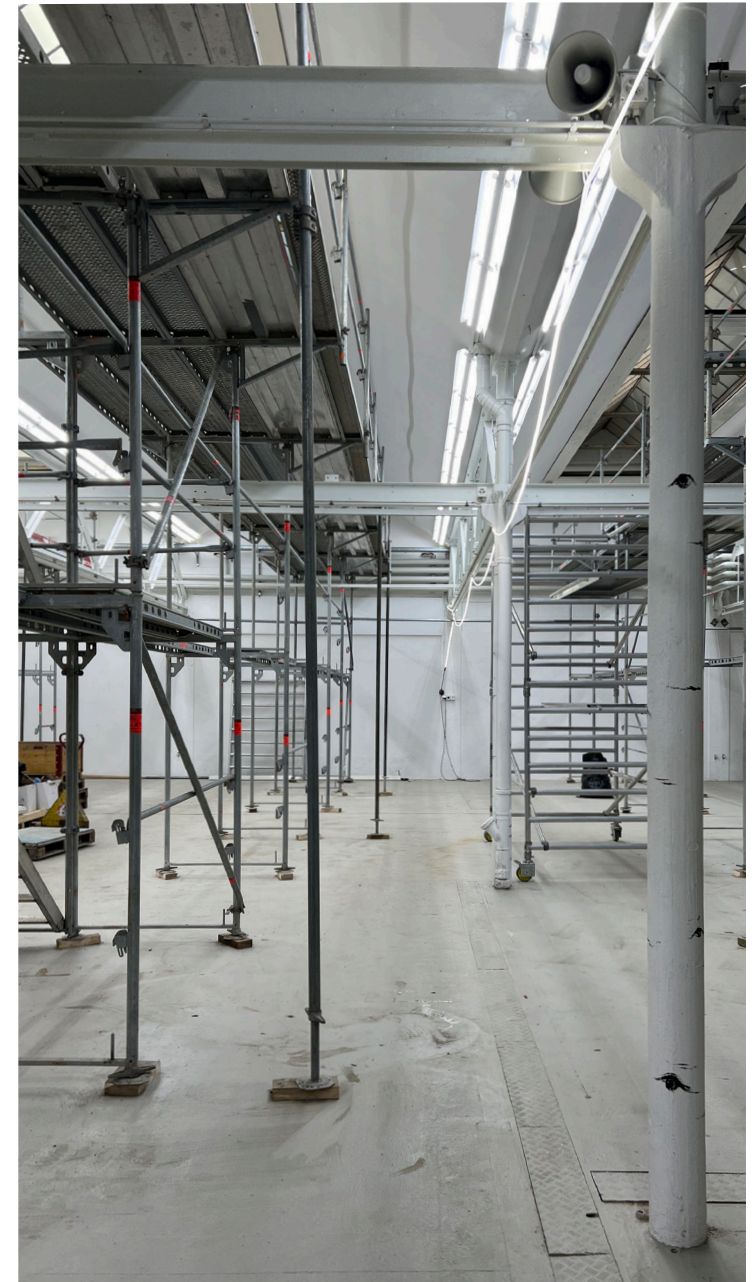
Umbau der Shedhalle während der Winterpause
